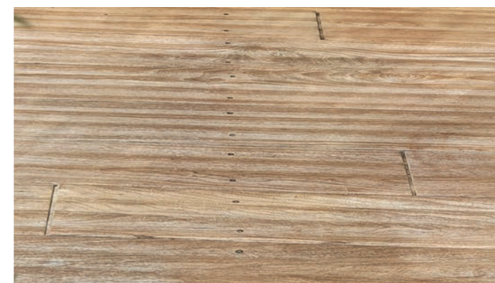
Zašedlá terasa z jasanového dřeva s termo úpravou po aplikaci přípravku DeckDegrayer.
